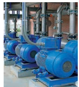
Estación de tratamiento del biogás
